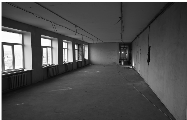
Ремонт идёт по плану
